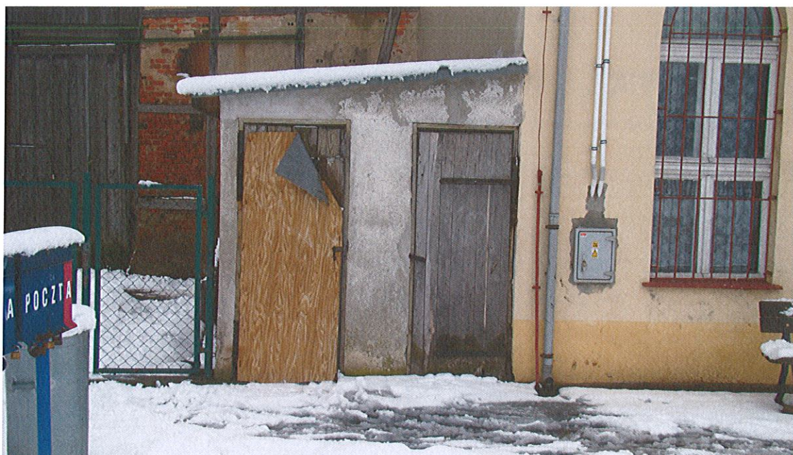
Fot. 4 Przybudowane sanitariaty.
