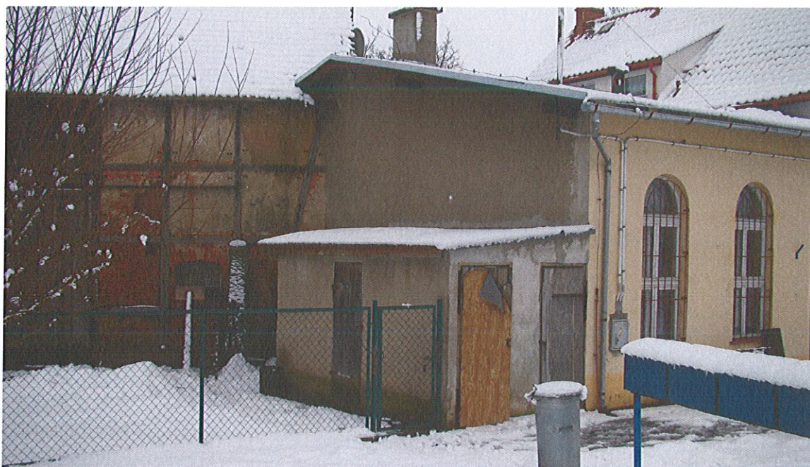
Fot. 5 Przybudowane sanitariaty.
