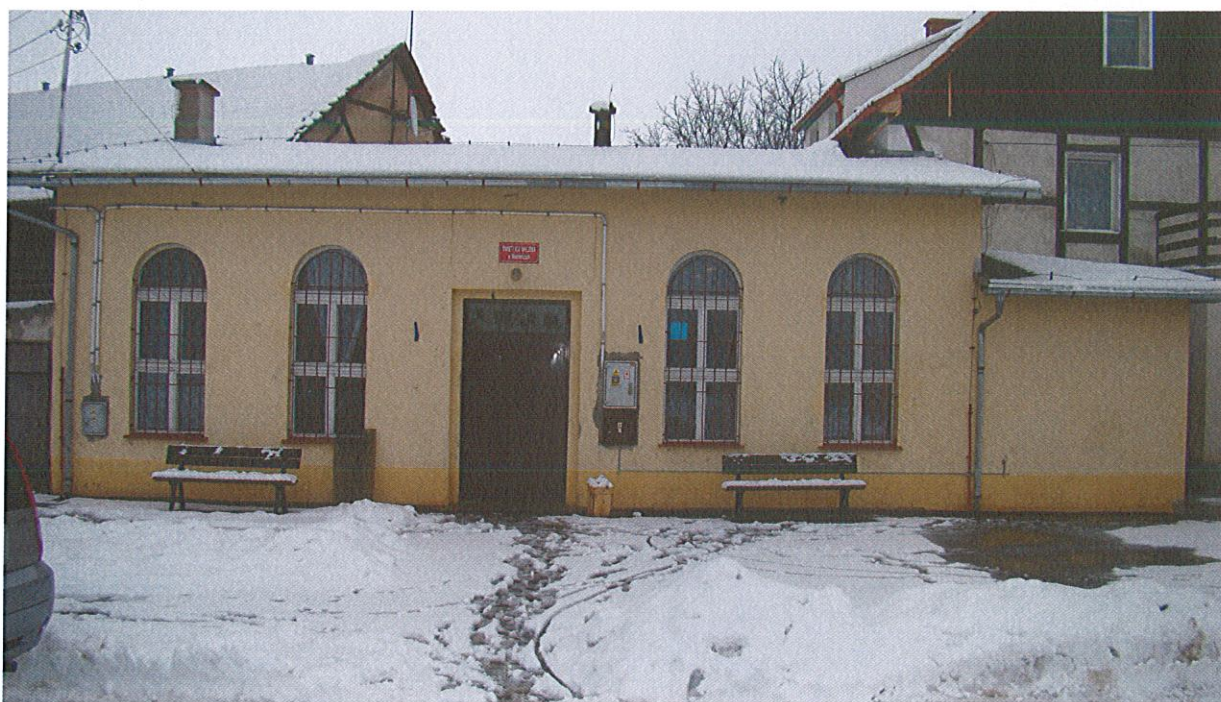
Fot. 3 Elewacja frontowa.
