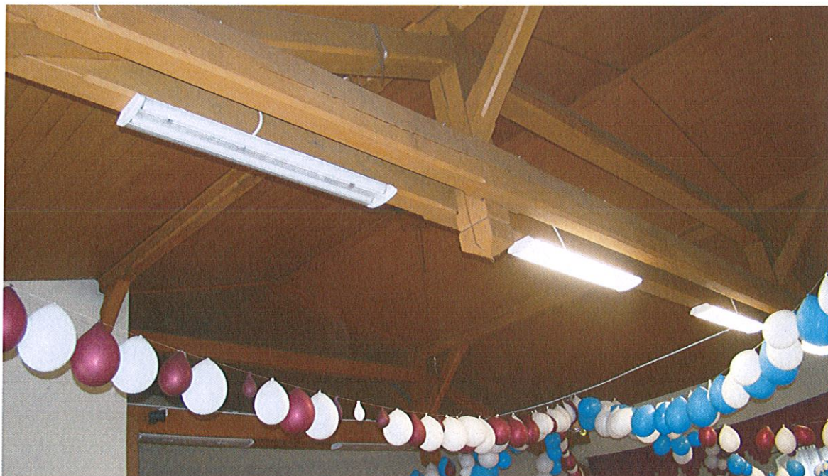
Fot. 1 Istniejąca konstrukcja dachu.
